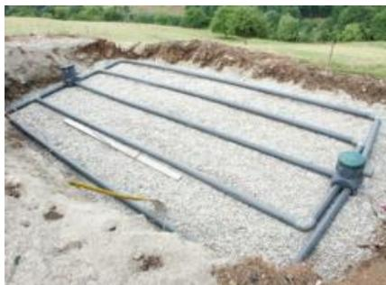
Exemple de lit filtrant non drainé vertical
